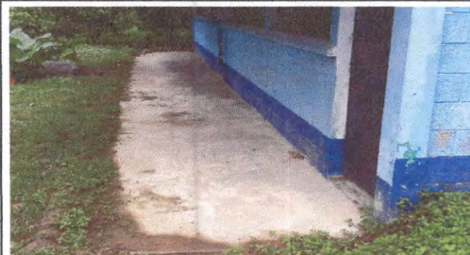
Foto 10: Reparación de piso de torta de concreto
