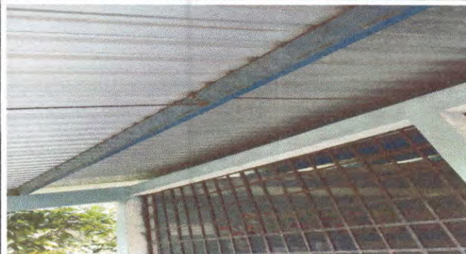
Foto 8: Mantenimiento a soporte de estructura de metal.
