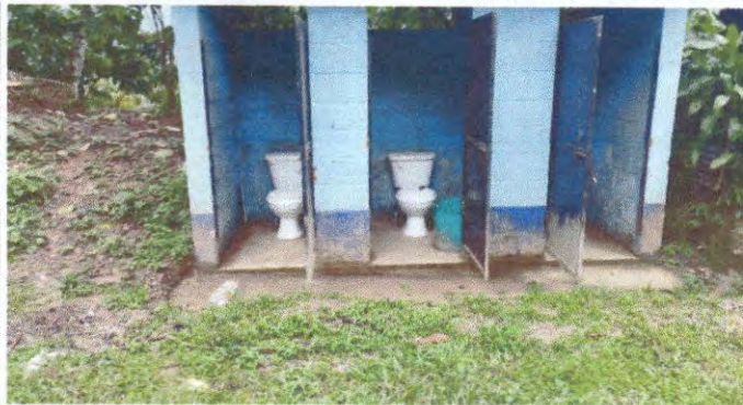
Foto 1: Mantenimiento a estructura puertas (lijado, cambio de tubo, cepillado, sujeciones, aplicación de pintura), modulo de baño.
