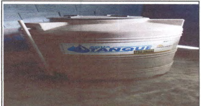
Foto 4: Sustitución de deposito de agua 1100 lt
