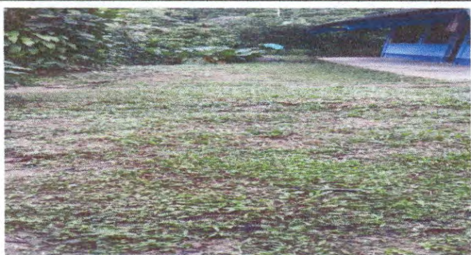
Foto 9: Sustrucción de tubería PVC, línea principal de aguas negras
